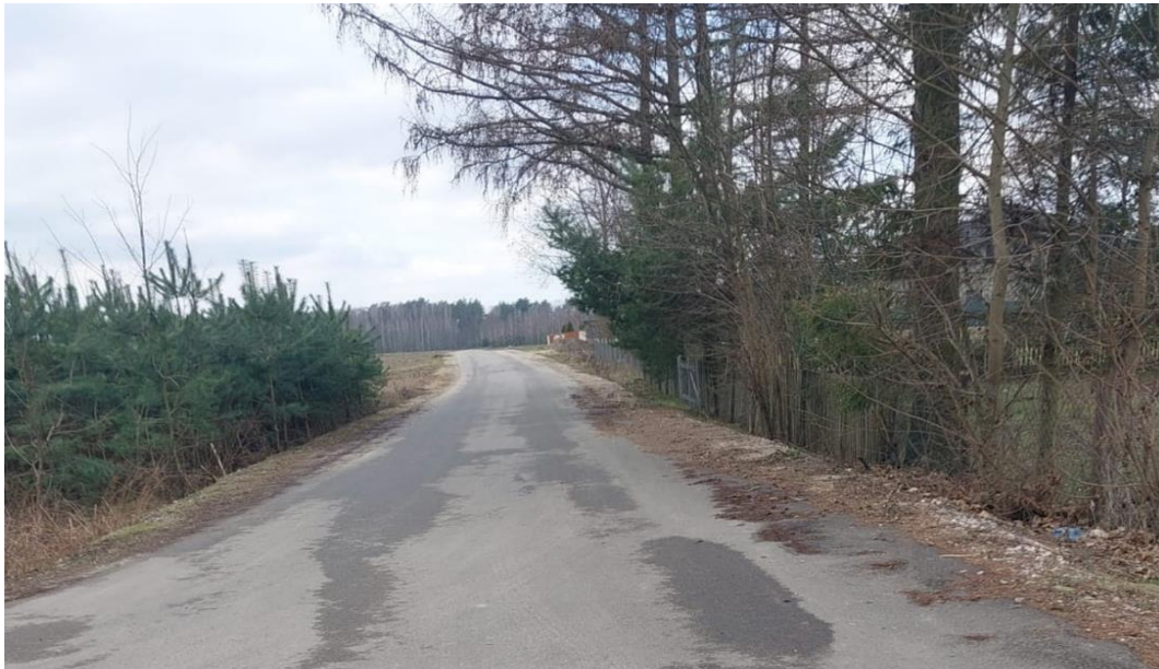
Budowa drogi gminnej w miejscowości Chruszczewka, 174,29 m, koszt: 131 524,83 zł
