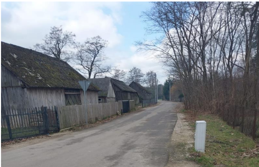
Budowa drogi gminnej nr 390407W w miejscowości Chruszczewka, 181,60 m, koszt: 112 659,84 zł
