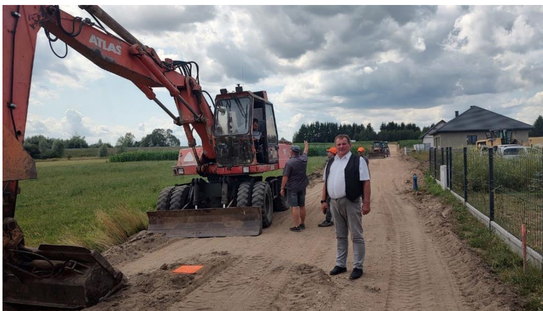
Budowa ul. Ogrodowej w miejscowości Kosów Lacki, 376,12 m, koszt: 222 417,82 zł
