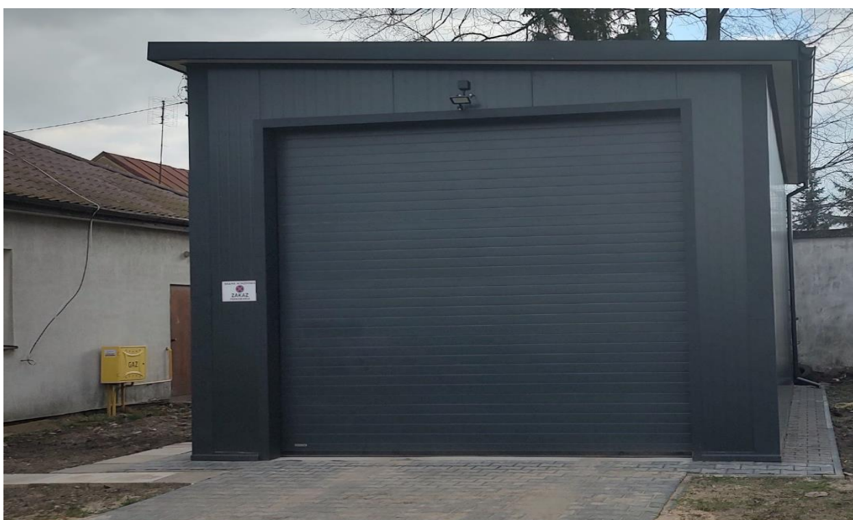
Budowa nowego ogrzewanego garażu na potrzeby karetki, koszt: 67.000,00 zł.
